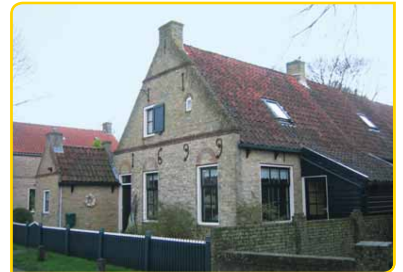
In de zeventiende en achttiende eeuw brachten walvisvaarders Ameland grote welvaart. De walviskapiteins werden commandeurs genoemd. Diverse zogenaamde commandeurshuizen herinneren aan deze periode. De huizen zijn te herkennen aan een dubbele rij uitstekende richelsteentjes in de voorgevel, terwijl met ijzeren ankers het bouwjaar is aangegeven. De binnenmuren zijn veelal versierd met fraaie tegels.
